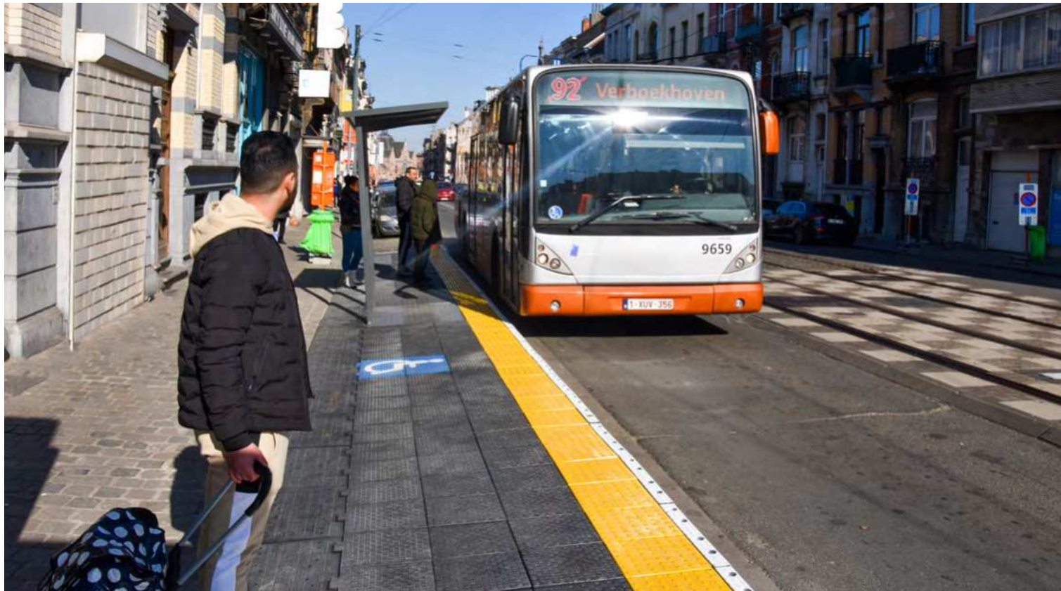
Plateforme de bus Vectorial® en en extension de trottoir au niveau de l'av de la Princesse Elisabeth.
