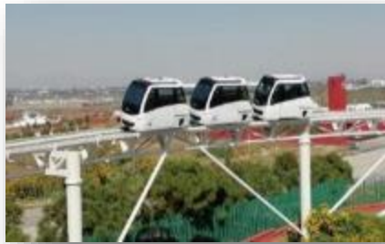
Modutram en aérien (Mexique) Infrastructures chères
